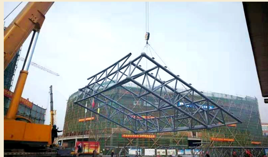
▲ 泸职院两馆项目钢构第一榀管桁架顺利完成吊装
